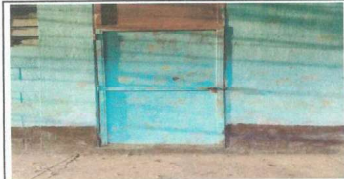
Foto 6: puerta de metal deteriorada en pintura y partes oxidadas.
